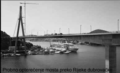
Probno opterećenje mosta preko Rijeke dubrovačke
