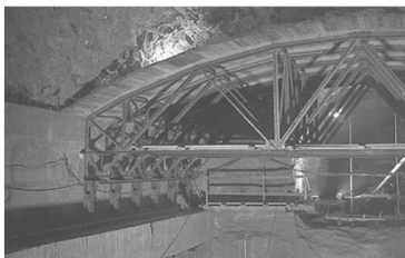
Kaufue Gorge izvedba strojarnice
